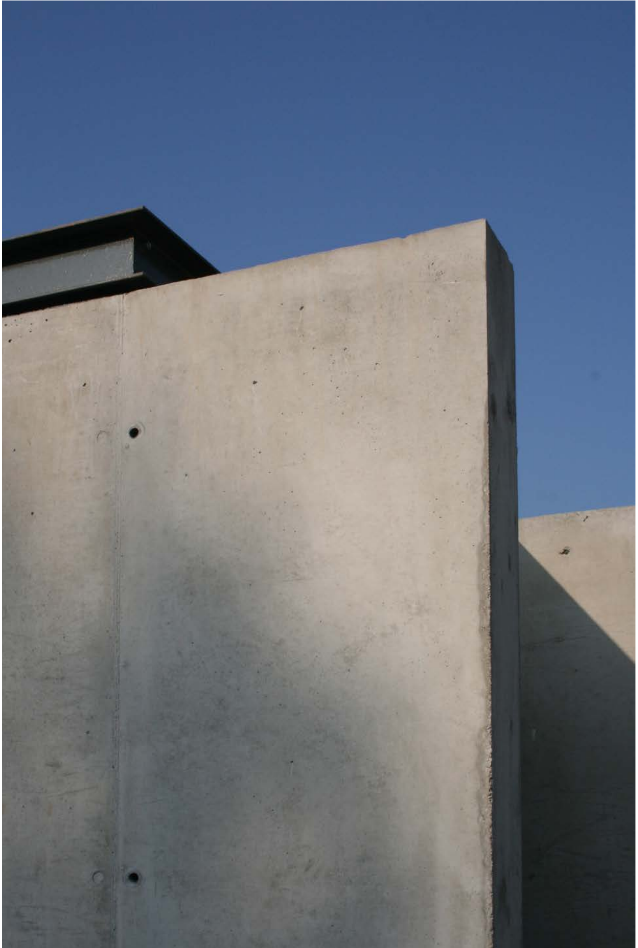
SAB 07 piscine et dépendances
